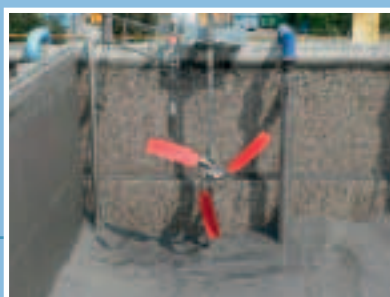
Этапы запуска погружного радиального аэратора.
