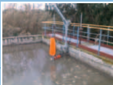
Этапы запуска погружного радиального аэратора.
